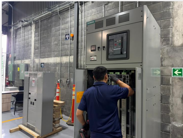
Ensamblado de tableros
